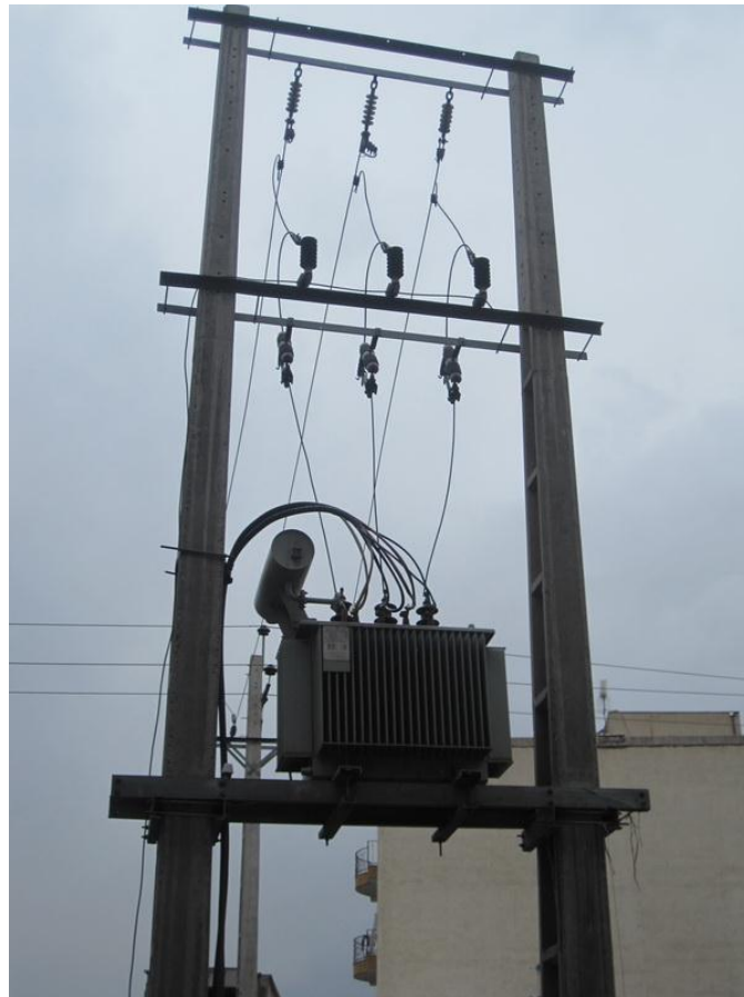
شکل (۲-۵): ترانسفورماتور قرار گرفته بین دو پایه در پست توزیع هوایی
