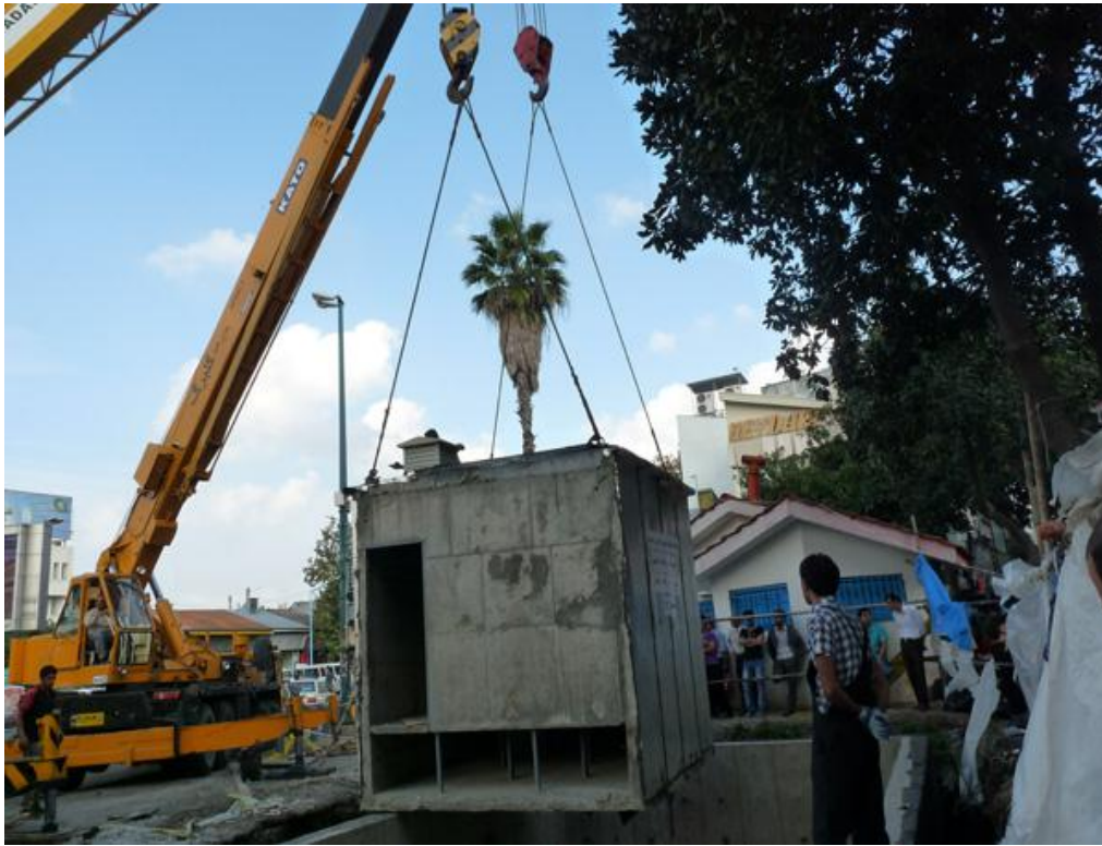
شکل (۲-۱۰): بدنه بتنی پست کمپکت زیرزمینی در حال نصب در جایگاه آن
