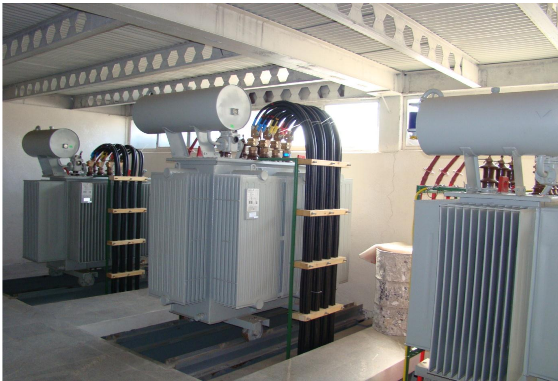
شکل (۲-۴): ترانسفورماتورهای قرار گرفته در پست زمینی توزیع
